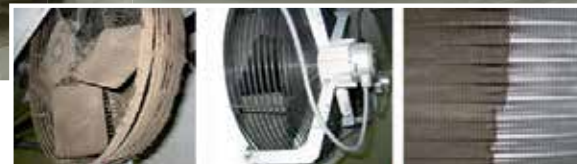
Het resultaat van vóór en ná het technisch reinigen en desinfecteren.
