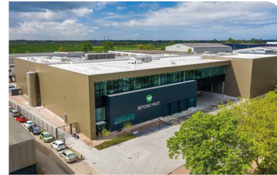
Voor The New Plant/Zandbergen is in samenwerking met RBK Food Projects een gebouw neergezet dat zijn tijd – zeker qua duurzaamheid – nog steeds ver vooruit is
